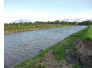
Canalización de ríos
