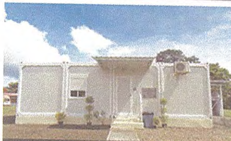
Centro de Diagnóstico de Enfermedades Desatendidas, Metetí Darién.
