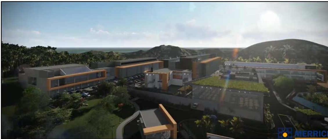
Vista panorámica del futuro "Campus Gorgas".
