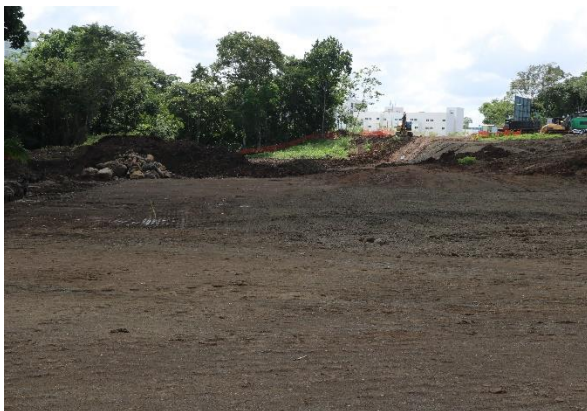
Retiro de capa vegetal y movimiento de tierra.
