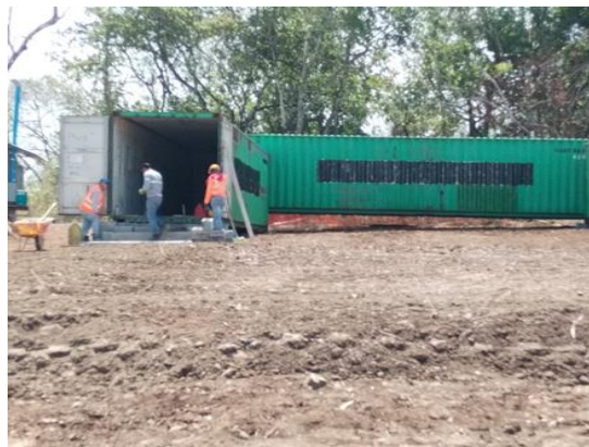
Instalación de contenedores para oficina administrativa.
