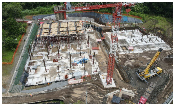
Construcción del edificio G1
