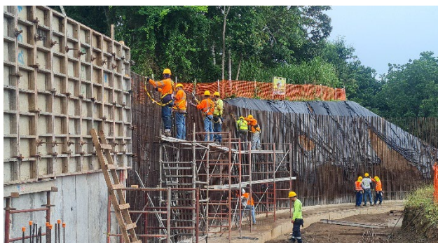
Obras geotécnicas (muro de contención)
