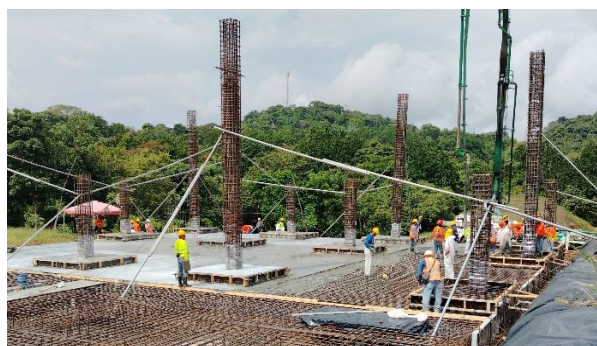
Construcción del nivel 000 del edificio G1
