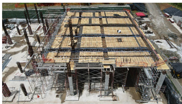
Construcción del nivel 100 del edificio G1
