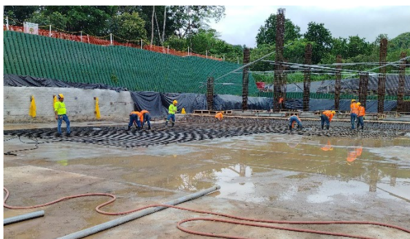
Inicio de la construcción del edificio G4
